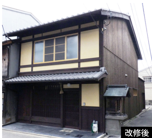
京町家の再生・改修事例
