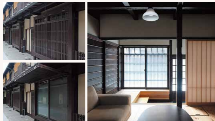
開け放つと庇にもなる出格子
