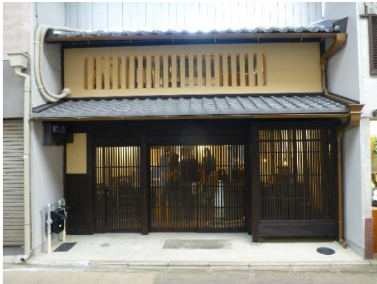
ア：京町家の改修事例
