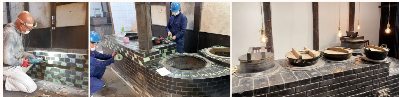
〈オクドサンの移設に向けた撤去工事〉
