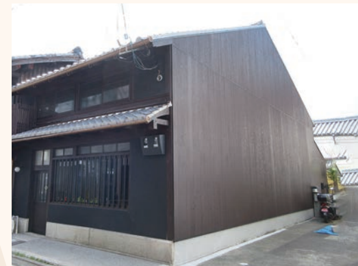
上【改修後】奥ノマ 下【改修後】妻面に杉板を張る
