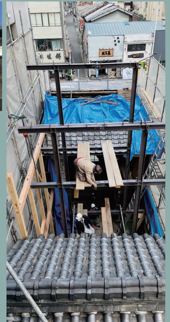
▲【工事中】鉄骨フレーム設置の様子
