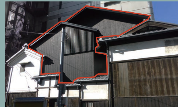
▲東側側面(赤枠は増築部分) 増築・改修部分の真新しいしっくい壁と元のまま残した少しくすんだ色のしっくい壁が対照的に積み重ねてきた歴史の風合いを醸し出しています。
