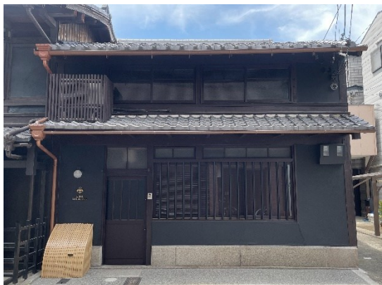
ア：京町家の改修
