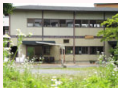
みんなで改修した本館
