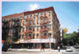
1階にショップが入った改修住宅の事例
