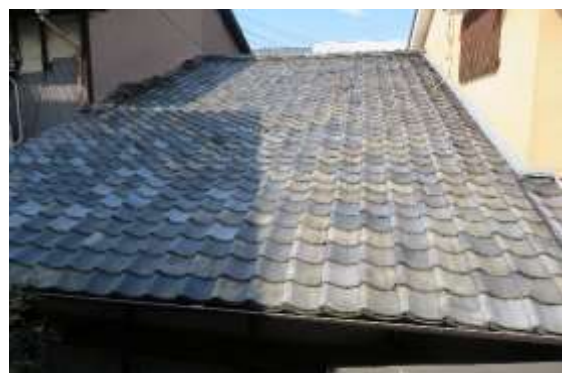
改修前の様子
